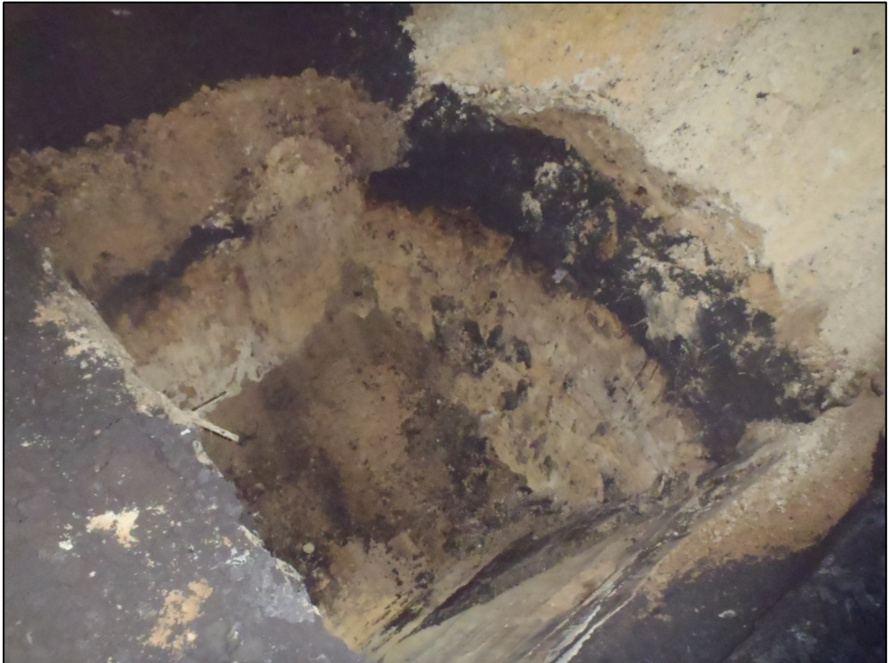
Abb. 6: Bodenschichtung in Schurf S 3
