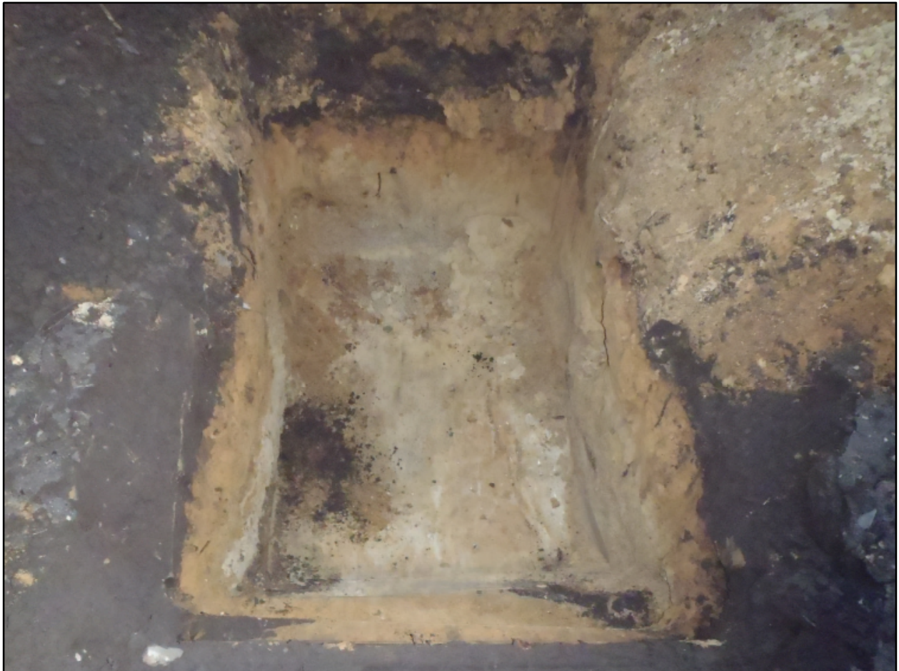
Abb. 7: Bodenschichtung in Schurf S 4
